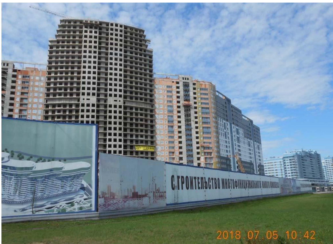
Ограждение строительной площадки
