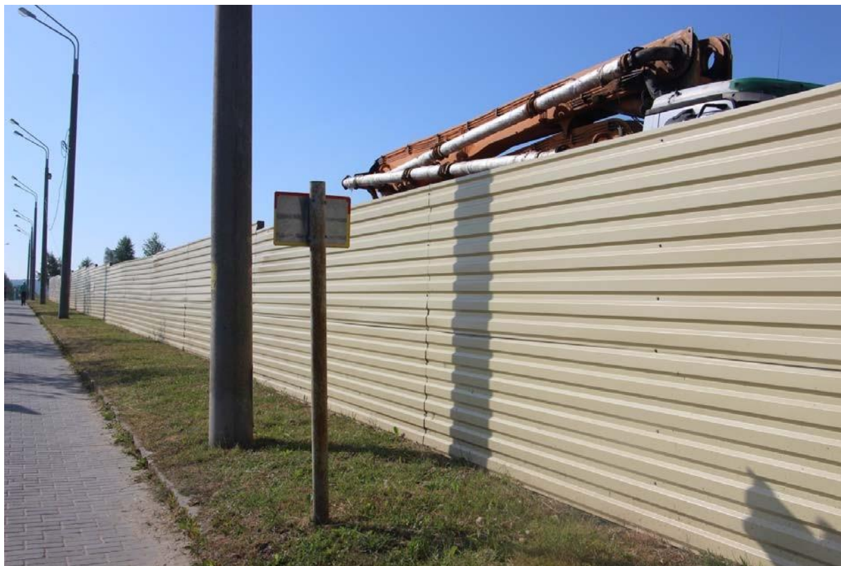
Ограждение строительной площадки
