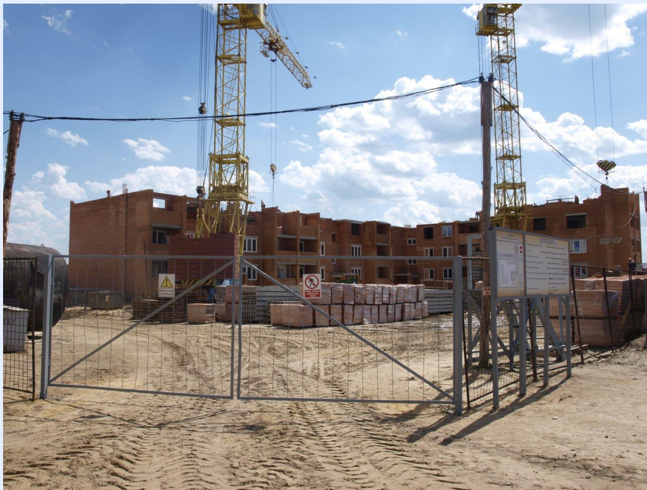
Въезд на строительную площадку
