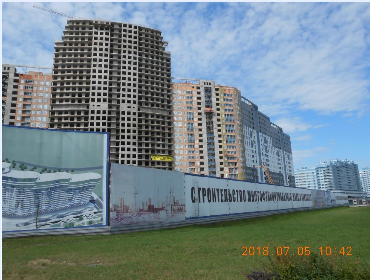
Ограждение строительной площадки
