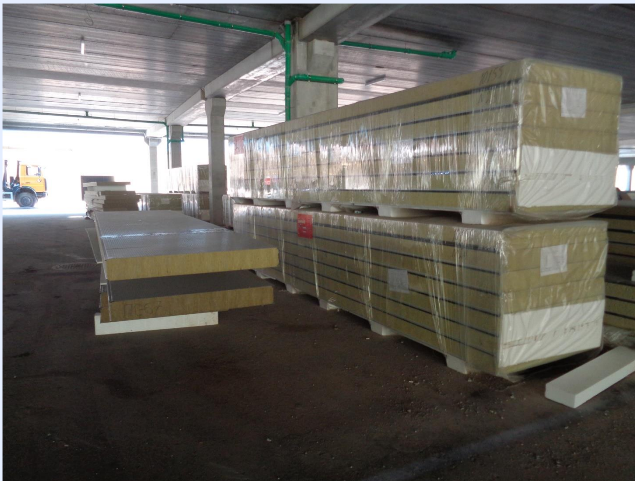
Площадка складирования материалов
