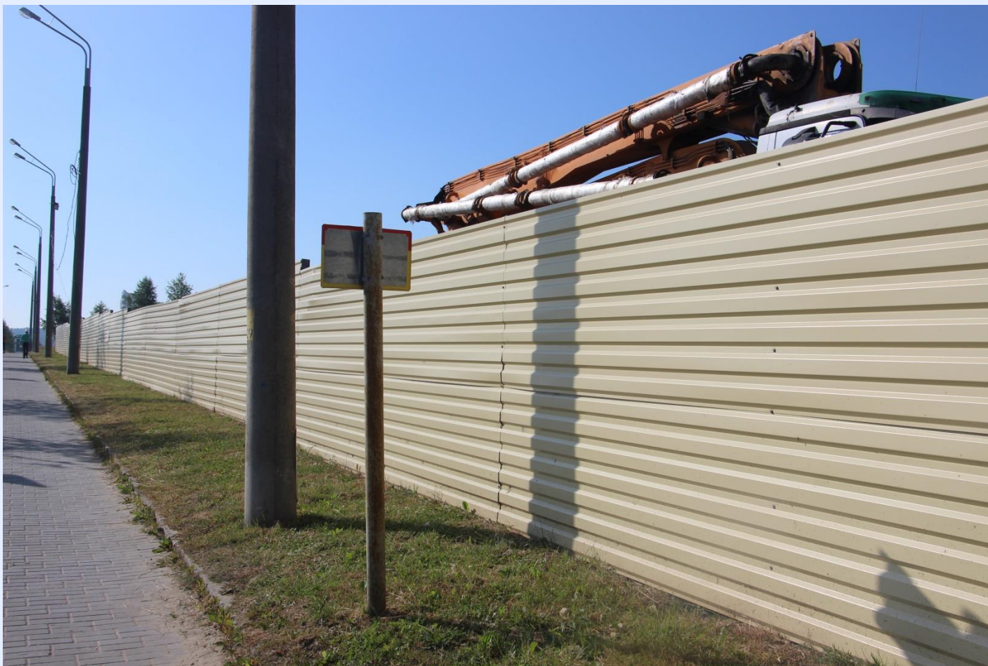
Ограждение строительной площадки
