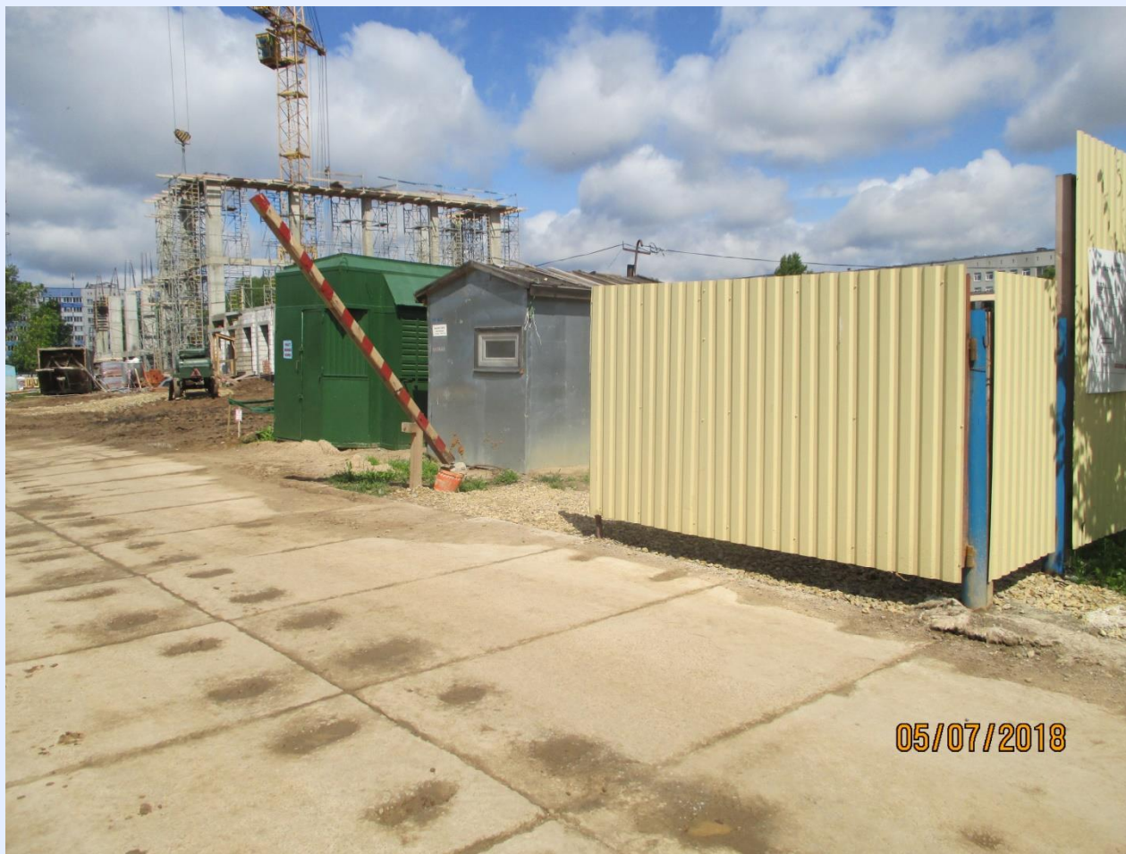
Въезд на строительную площадку
